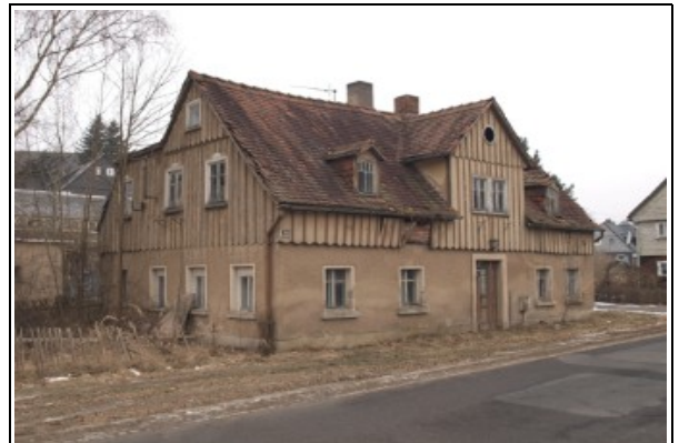
straßenseitige Ansicht des ruinösen Wohnhauses aus Richtung Osten
