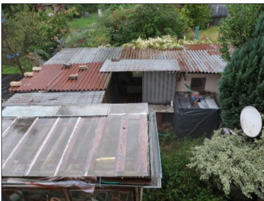
Blick auf die Anbauten an der Veranda
