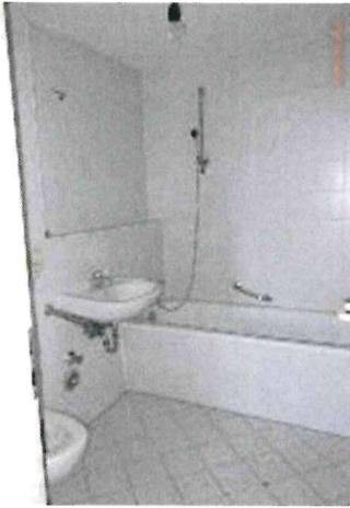
Bad der besichtigten Leerwohnung Nr. 20
