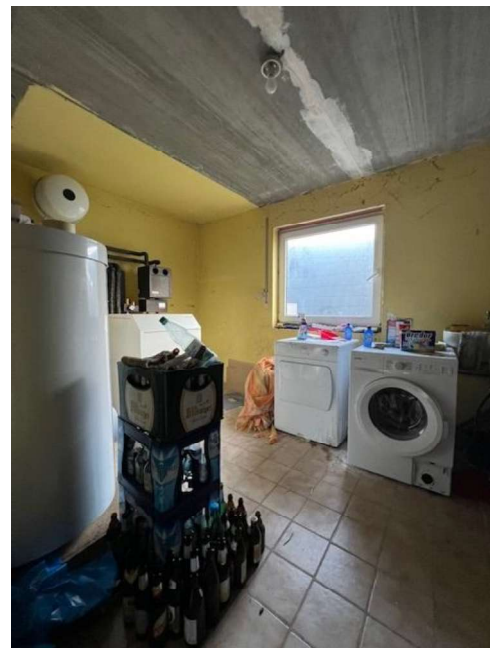
Bild 8: Waschküche und Heizungsraum im EG
