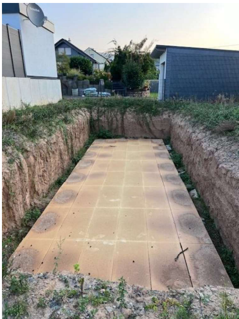
Bild 23: Ausschachtung für Schwimmbad
