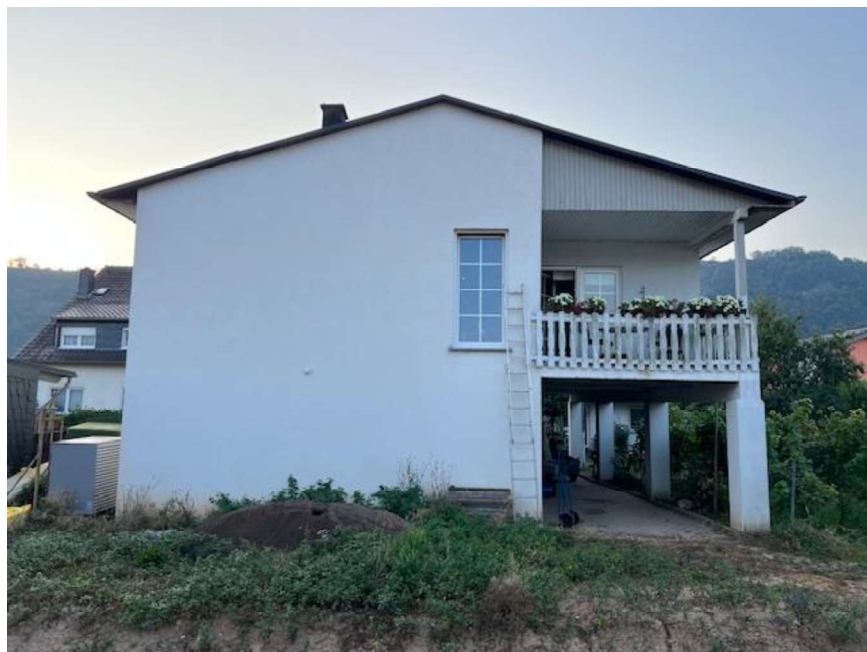
Bild 4: Rückansicht des Bewertungsobjekts aus nordwestlicher Richtung
