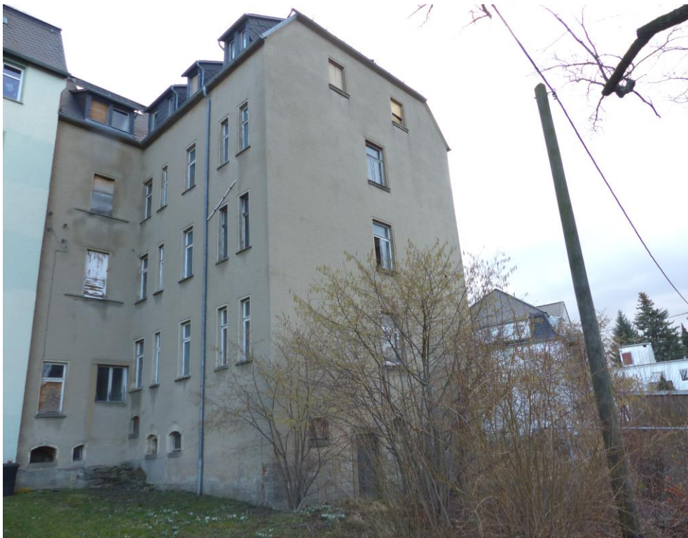
West-Ansicht zur Gebäuderückseite
