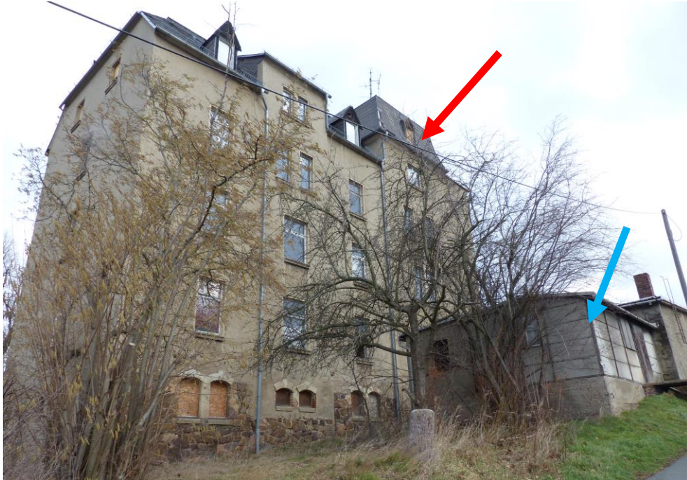
Süd-West-Ansicht von der „Jahnstraße“ (rot: Wohnhaus, blau: Schuppen)
