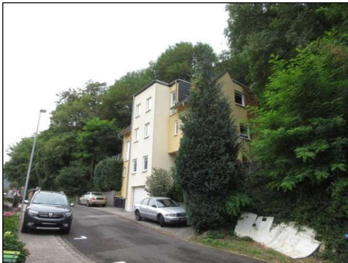
Südlicher Grenzbereich u. Nachbar
