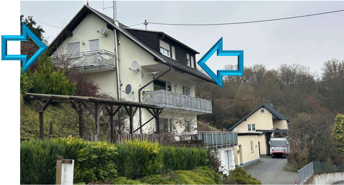
Bild B4 Straßenansicht
