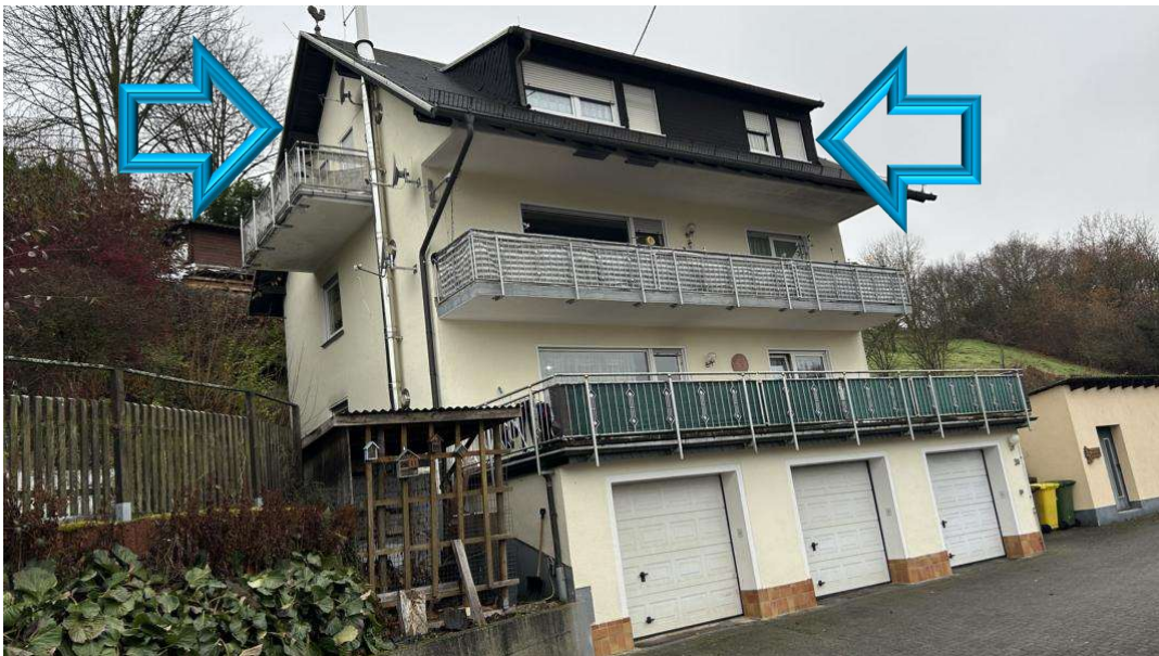
Bild B1 Straßenansicht
