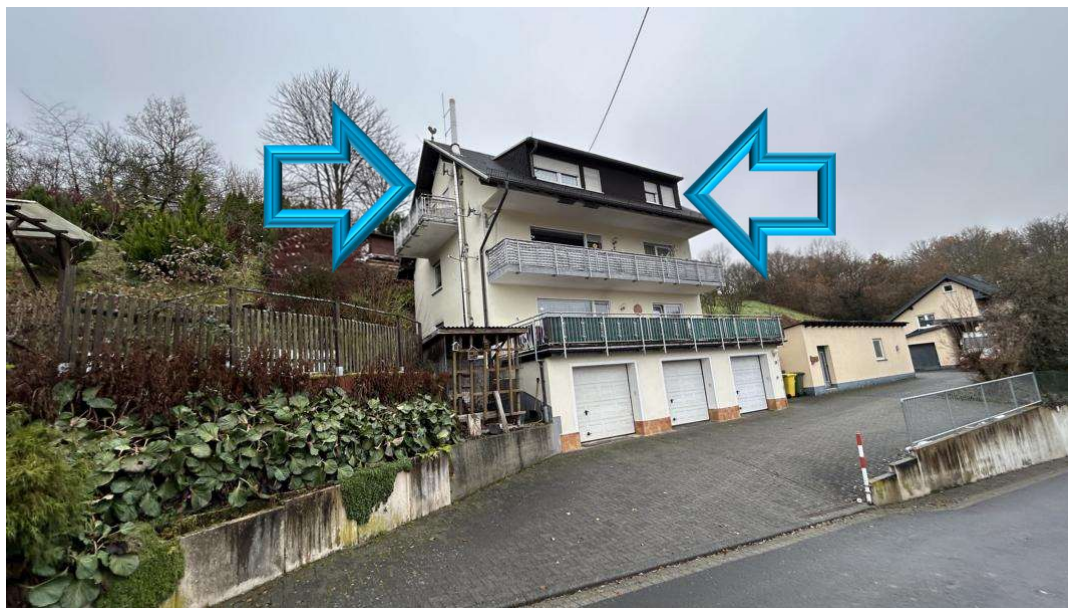
Bild B3 Straßenansicht
