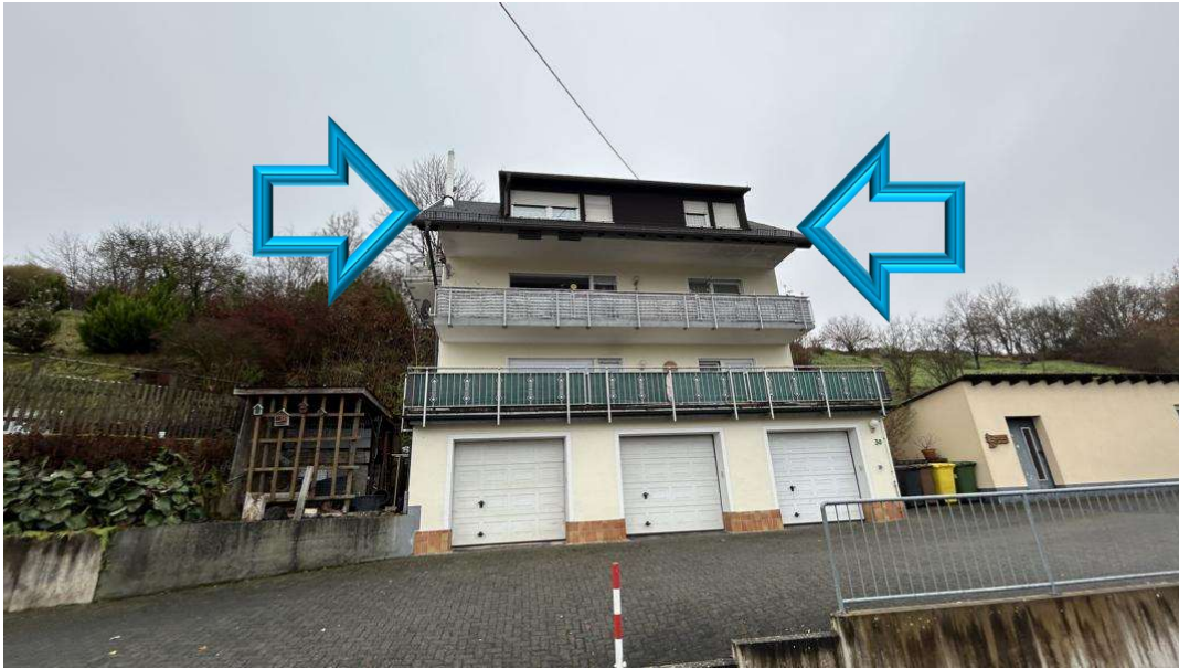
Bild B2 Straßenansicht
