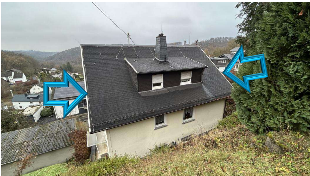
Bild B5 Gebäuderückseite
