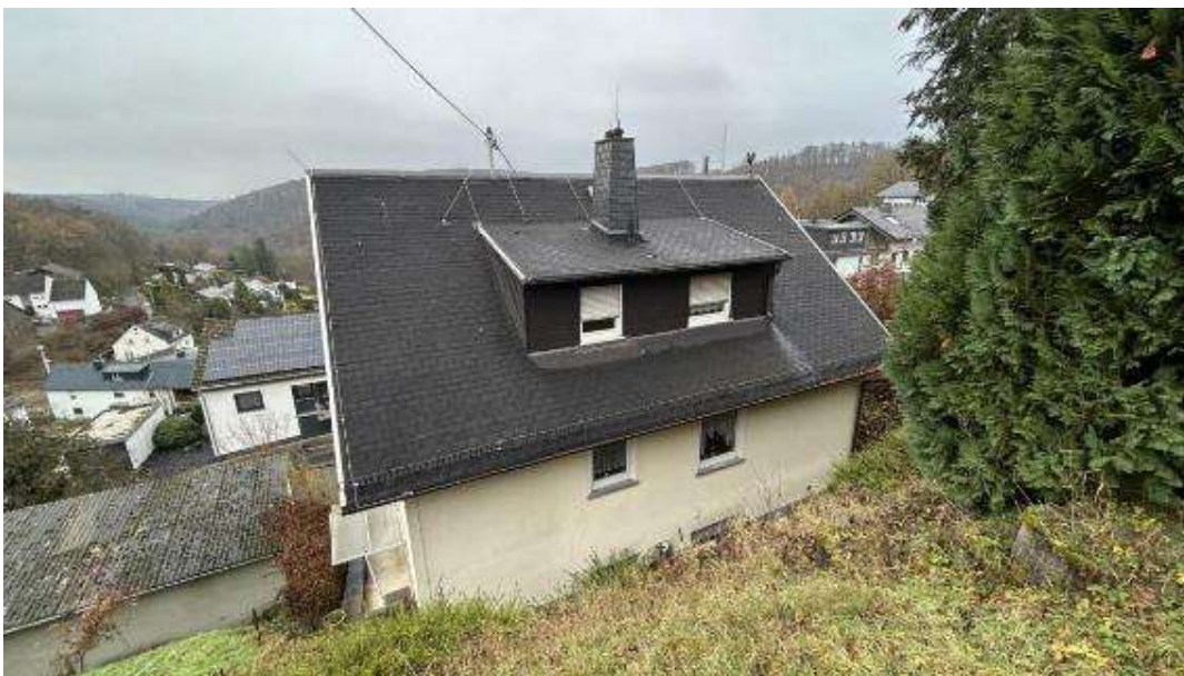
Bild B5 Gebäuderückseite
