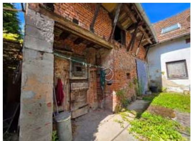
Bild 12 – Scheune des angrenzenden Flst.
