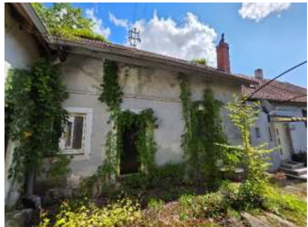
Bild 10 – Fassade und Nebeneingang
