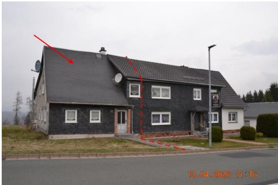
Straßenansicht Gesamtobjekt, zu bewertende Doppelhaushälfte links
