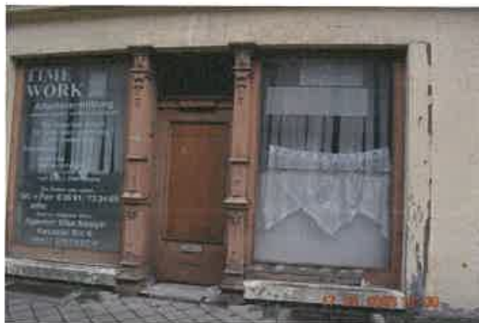
straßenseitiger ehemaliger Ladenbereich
