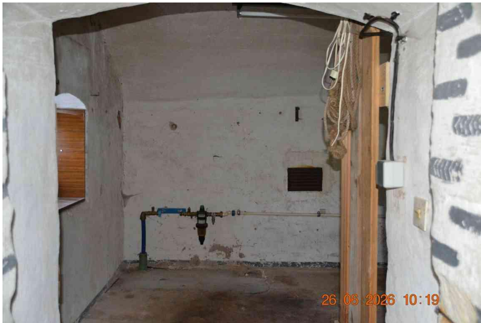
Bild 21: Kellerraum im Anbau
