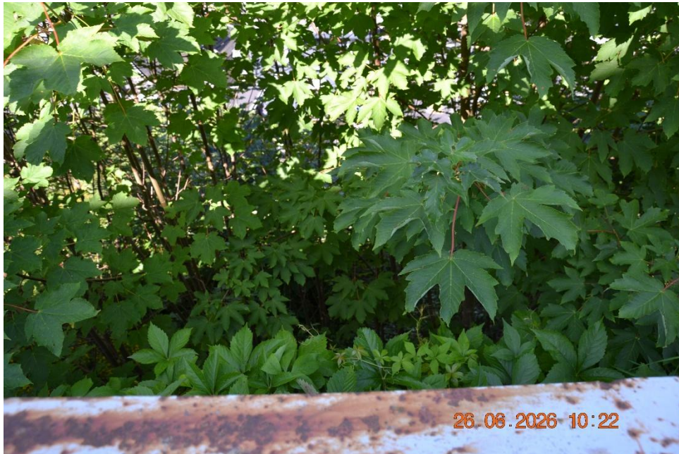
Bild 25: Flst. 255/6 unterhalb des Straßengeländers
