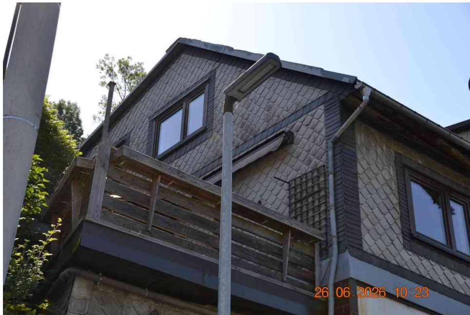
Bild 3: Giebelansicht (Ober- und Dachgeschoss)
