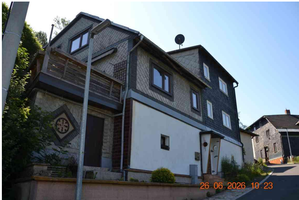
Bild 1: Straßenansicht des gesamten Doppelhauses
