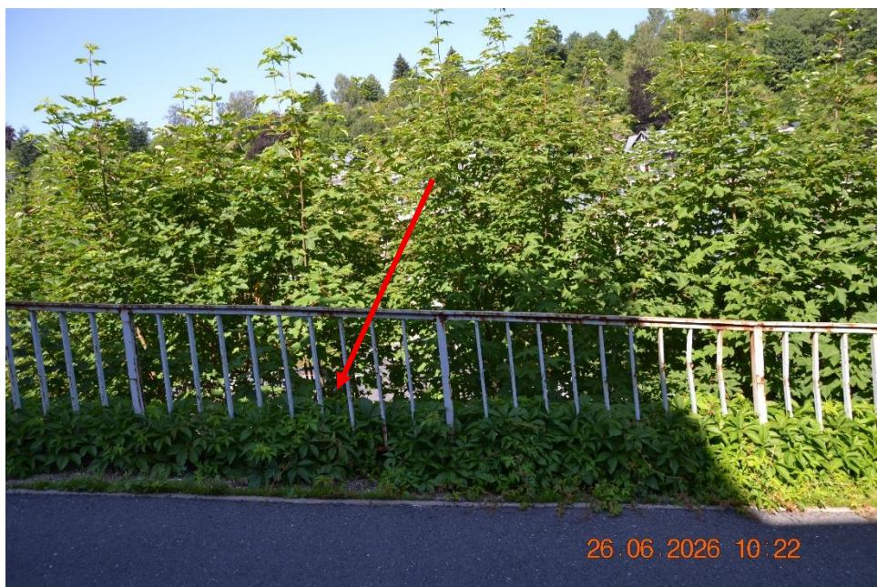
Bild 24: Flst. 255/6 unterhalb des Straßengeländers
