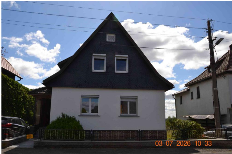
Bild 1: Straßenansicht aus westlicher Richtung
