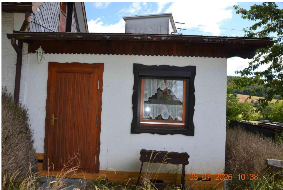
Bild 22: Anbau Gartenzimmer an Garage
