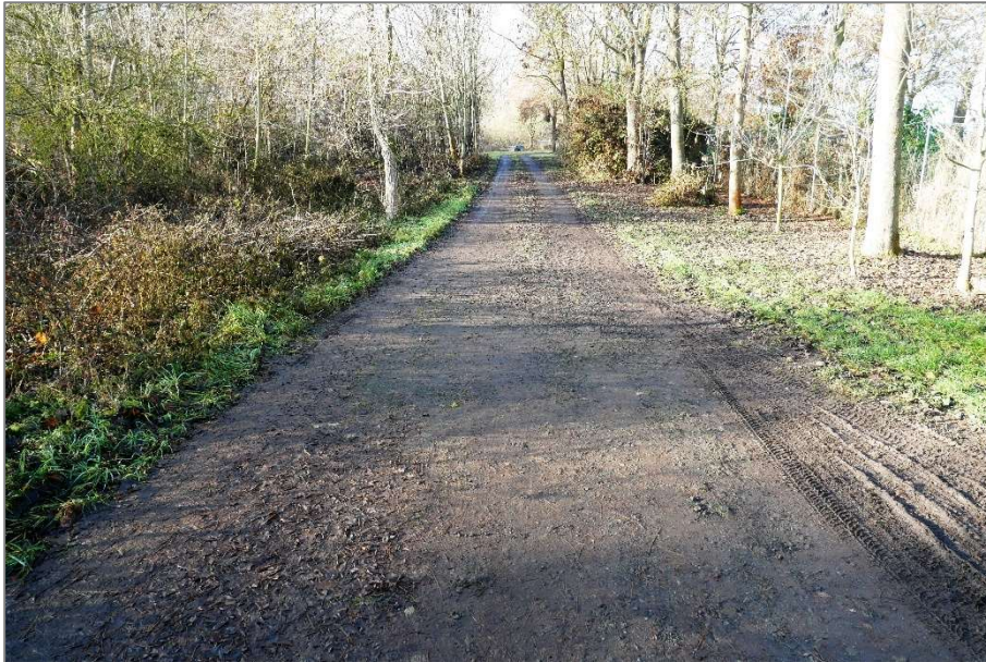
Zufahrtsweg zum Grundstück
