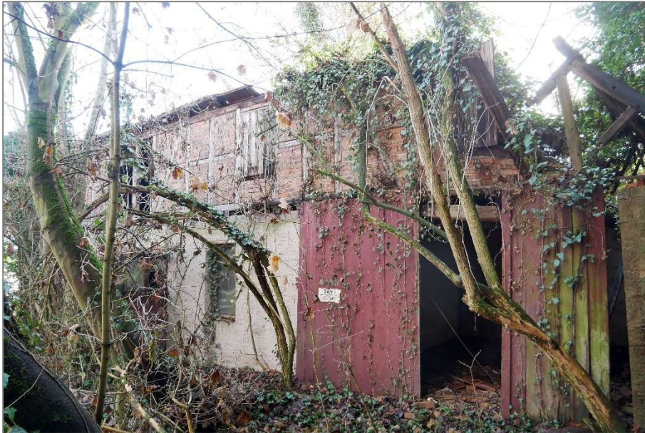
ostseitiger Anbau an der Scheune - Nordansicht
