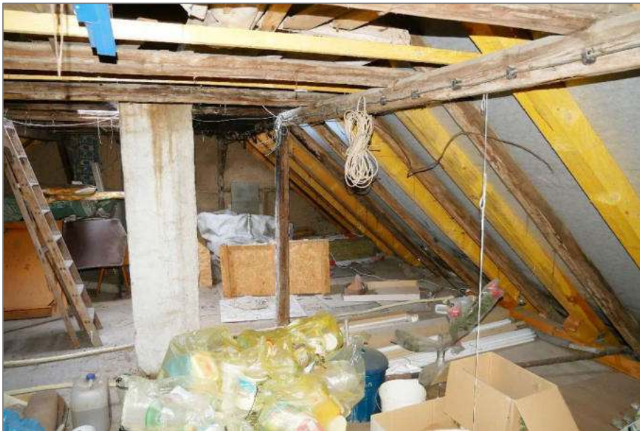
Foto 12 - Wohnhaus - nicht ausgebauter Dachboden
