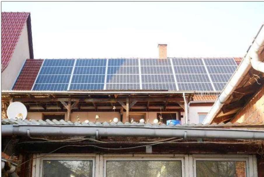
Foto 2 - Wohnhaus - Südansicht (Ober- und Dachgeschoss)
