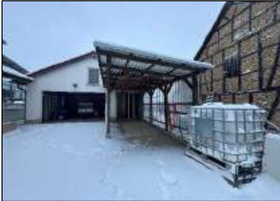
Hof-/Ostansicht - Nebenglass Garage mit vorgesetztem Carport und Garagentor
