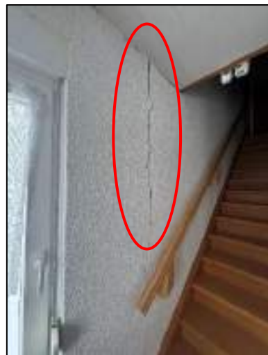
Setzungsrisse im Treppenhaus des Windfangs zum DG
