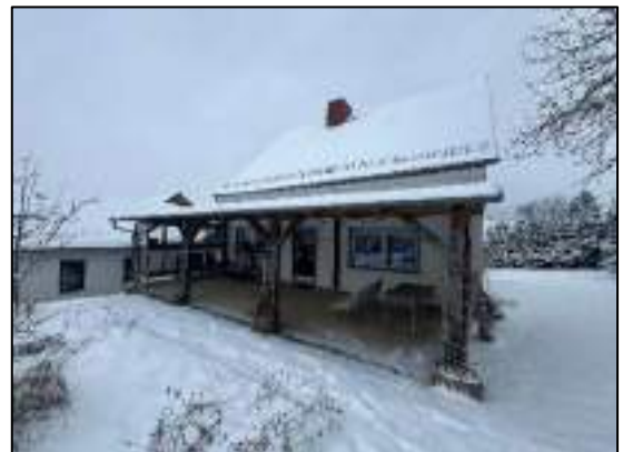
West-/Rückansicht - Einfamilienhaus mit überdachter Terrasse
