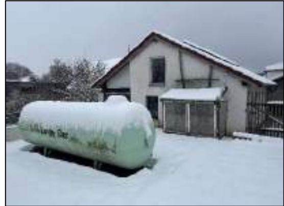
Rück-/Westansicht - Nebenglass Garage mit Flüssiggastank des Einfamilienhauses
