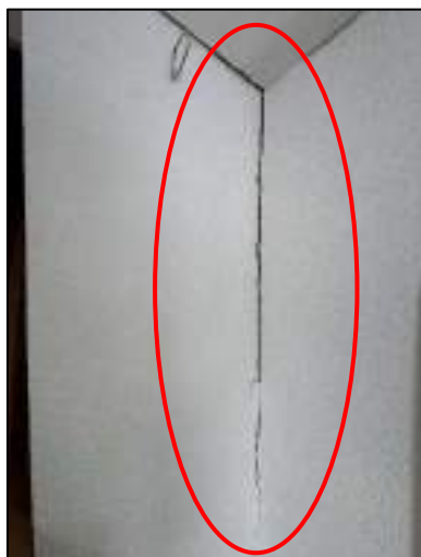
Setzungsrisse im Treppenhaus des Windfangs zum DG
