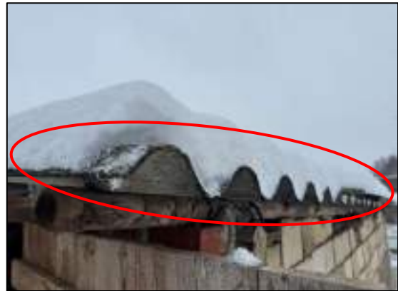
Mit Wellasbest eingedecktes Dach des ehemaligen Hühnerstalls
