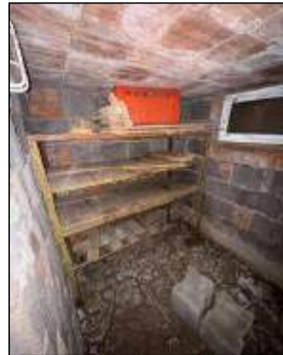
Innenansicht - Kellerraum im Nebenglass
