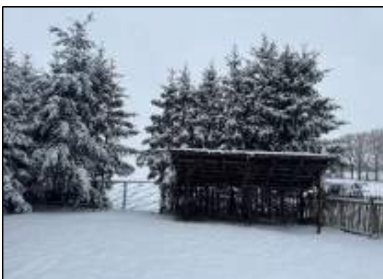
Westansicht - Westliche Grundstücksgrenze mit Flügeltor und einfachem Holzunterstand
