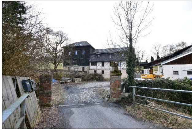
Wohngrundstück mit zu bewertender Eigentumswohnung Nr. 2, Lage und Zufahrterschließung über Brückenbauwerk, Ostansicht
