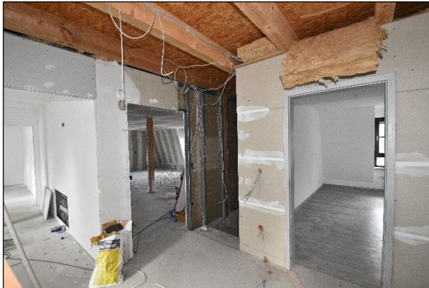
Ausgebauter Wohnbereich Dachgeschoss, Mittelflur mit Treppenaustritt
