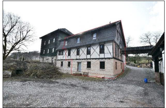
Nordostansicht mit zu bewertender Eigentumswohnung Nr. 2 (markierte rechte Gebäudehälfte sowie Hof- und Stellplatzbereich)
