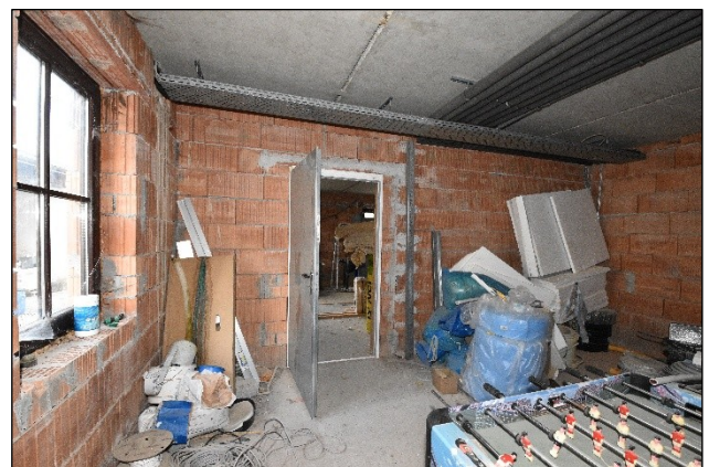
Erdgeschoss, Zimmer Nord
