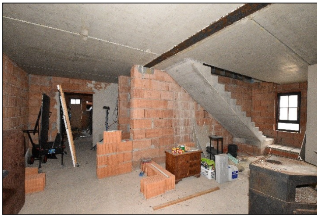
Obergeschoss, Flur / Treppenhais
