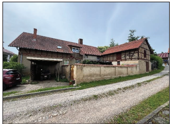
Ostansicht - Einfamilienhaus, Nebenglass und Zufahrt von der „Backhausgasse“
