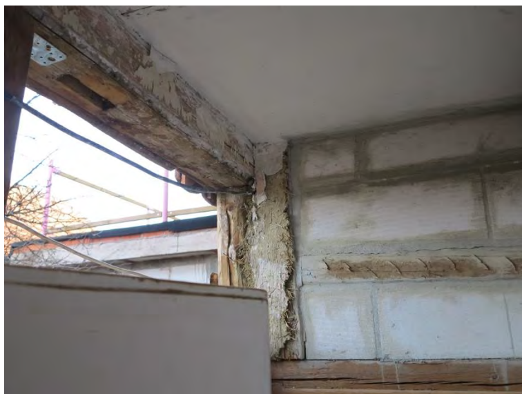
EG Vorraum mit offener Außenwand
