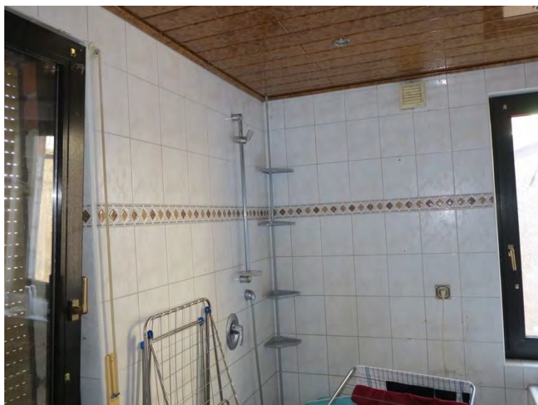
EG Bad 2 mit halbfertiger Dusche
