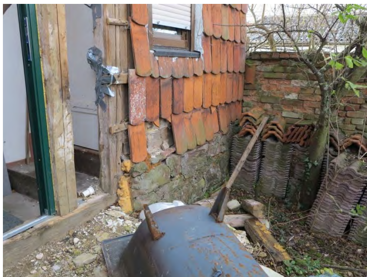
Westseite mit offener Außenwand
