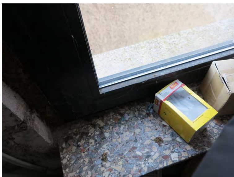
OG Fensterbank und Wandanschluss im Anbau
