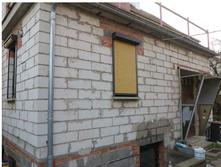
Balkonanbau, Eingang und Ansicht Westseite
