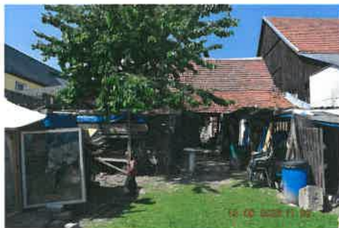
rückwärtige Ansicht Scheune/Schuppen
