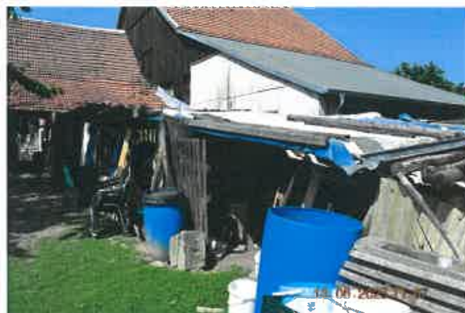
rückwärtige Ansicht Stall/Scheunengebäude mit Schuppen
