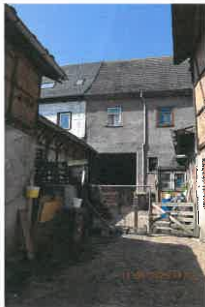
Hofansicht mit rückwärtiger Ansicht Wohnhaus
