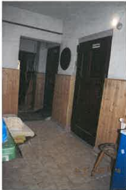
rückwärtiger Durchgang und Treppe zum Saal und Zugang ehemalige WC-Anlagen
