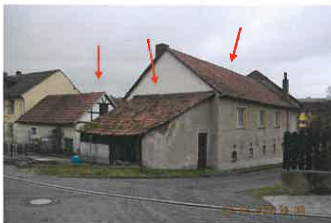
rückwärtige Ansicht Seitenflügel mit Schleppdachanbau, Hühnerhaus
