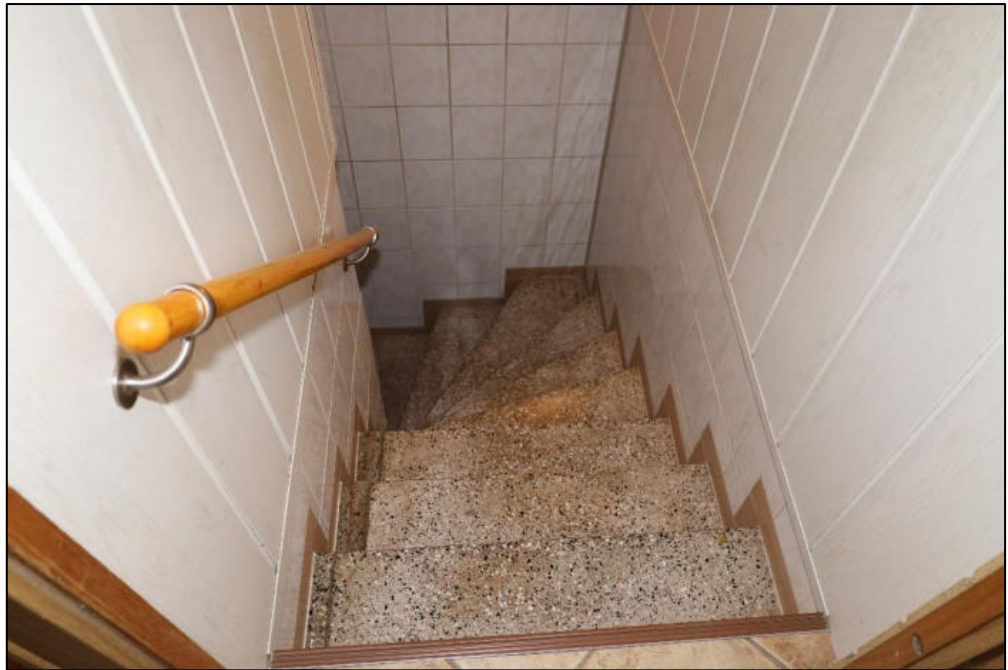
Treppe vom Erdgeschoss zum Kellergeschoss
