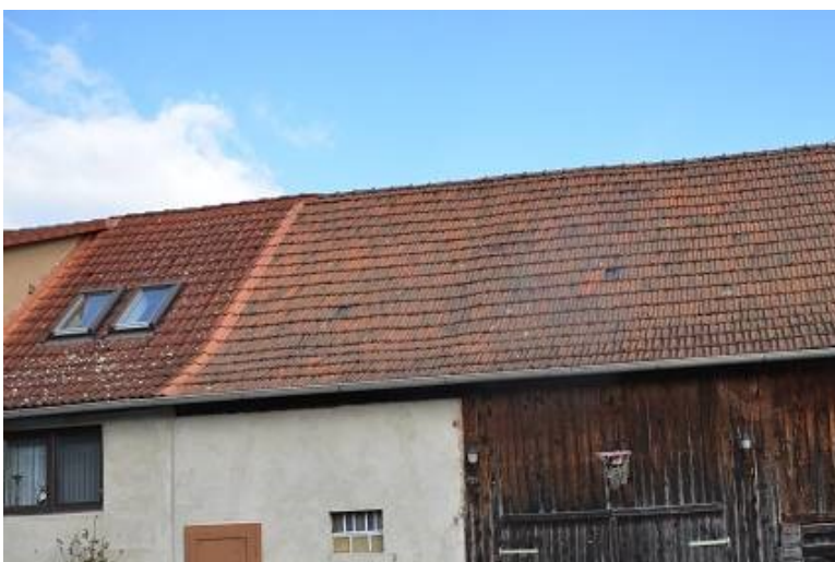
Foto 3 WEST- ANSICHT SCHEUNE
