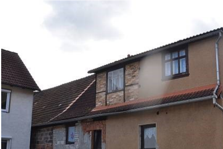
FOTO 1 NORD-OST ANSICHT VOM STRAßENRAUM
