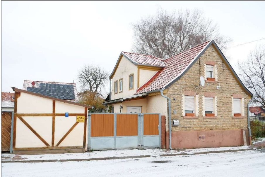
Wohnhaus und Schuppen - Südwestansicht
