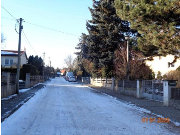
Bild 17: geschotterte Anliegerstraße An der Karlsquelle; Straßenausbau ab 3. Quartal 2026 geplant; Blick in westliche Richtung
