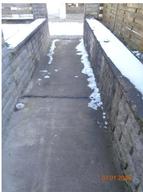
Bild 11: betonierter Gehweg zum Haus mit Stützmauern zum terrassierten Gartenbereich
