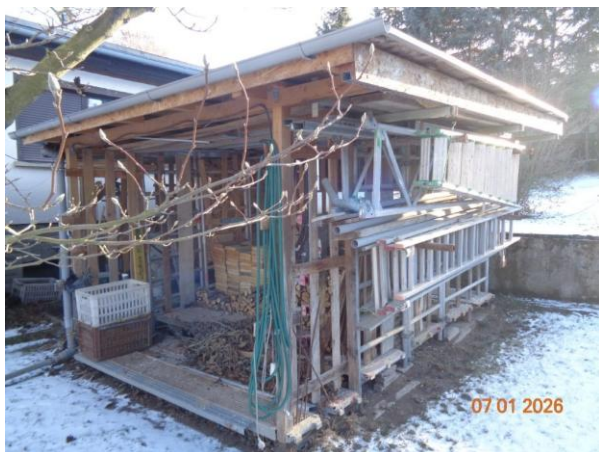
Bild 9: Holzschuppen im westseitigen Gartenbereich
