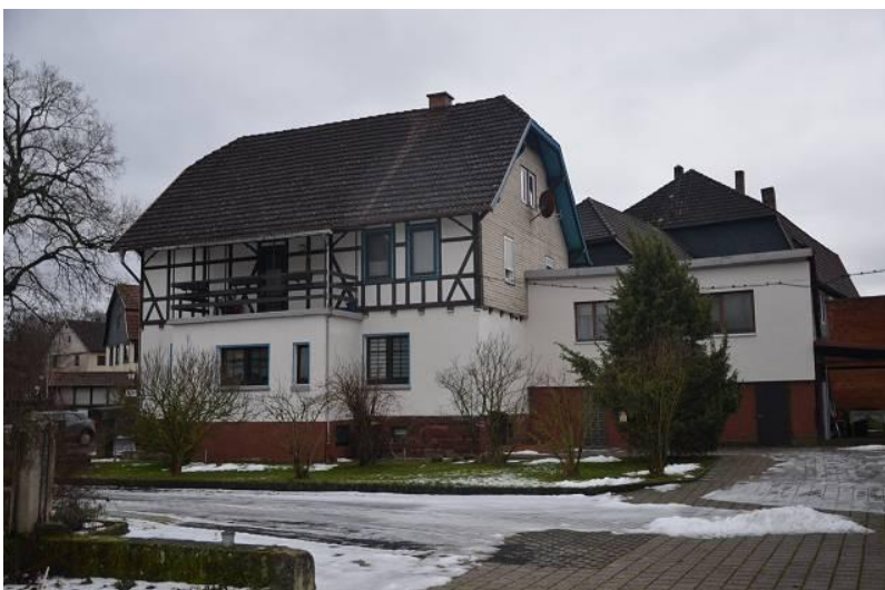
Foto 3 WESTANSICHT MIT KLEINEM NEBENGEBAUDE
