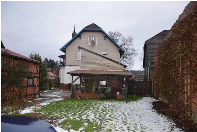
Foto 4 ANSICHT VOM HINTERRAUM SÜDANSICHT
