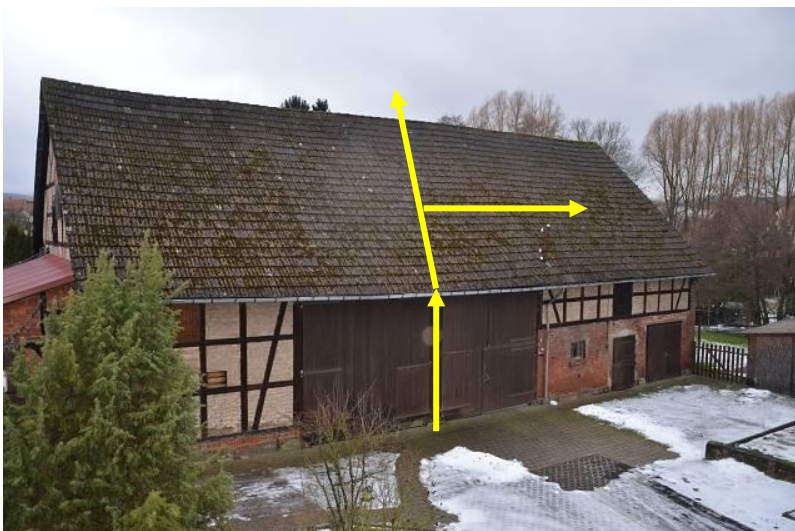
FOTO 3 BEBAUUNG FL. STCK 37/3 Nebengebäude
