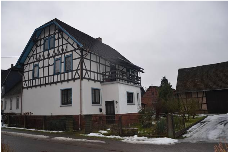
FOTO 1 BEBAUUNG FL. STCK 37/4 Wohnhaus Straßenansicht
