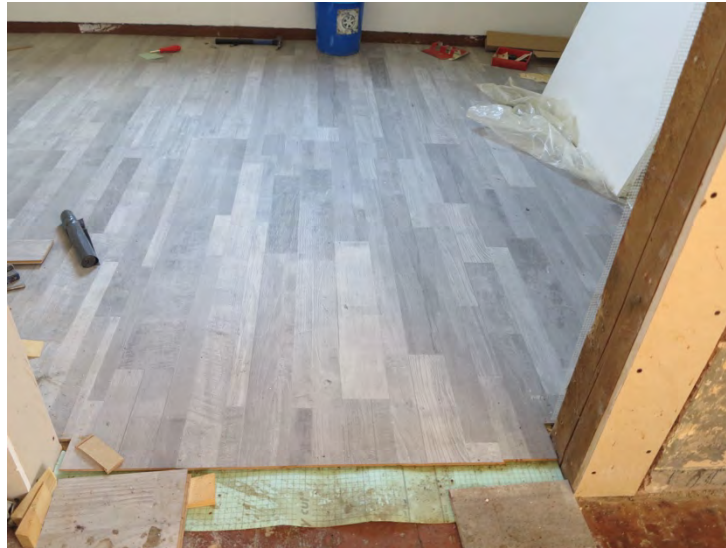
EG unfertiger Laminatboden
