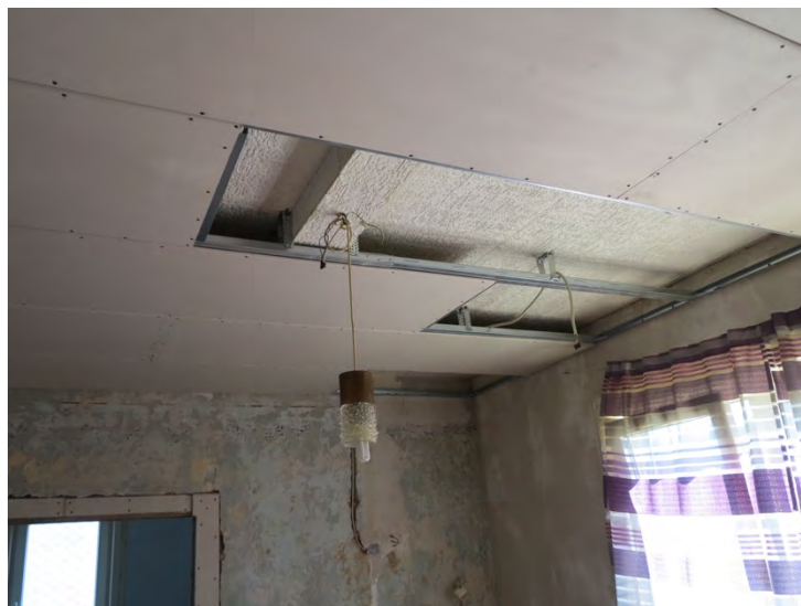
DG unfertige Zimmerdecke
