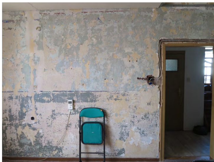
DG unfertige Wand
