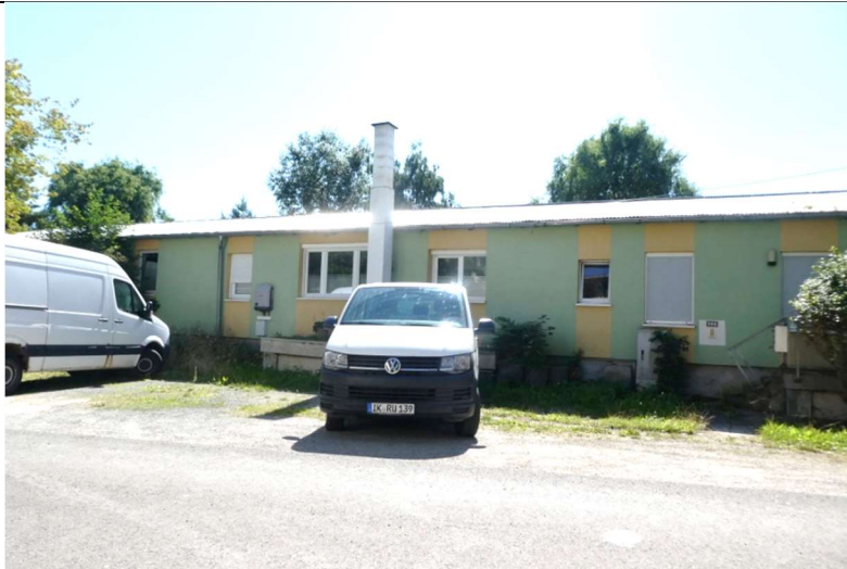
Ansicht vom Lohmühlenweg (Nordwest)
