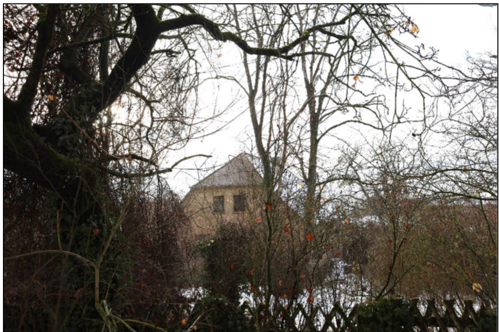
Nordostansicht – Wohnhaus mit Anbau
