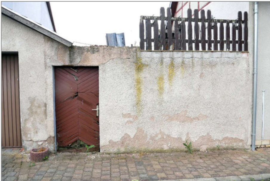
Foto 4 - Einfriedung mit Tür und Badanbau / Dachterrasse
