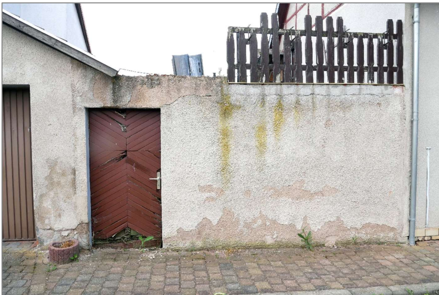
Einfriedung mit Tür und Badanbau / Dachterrasse
