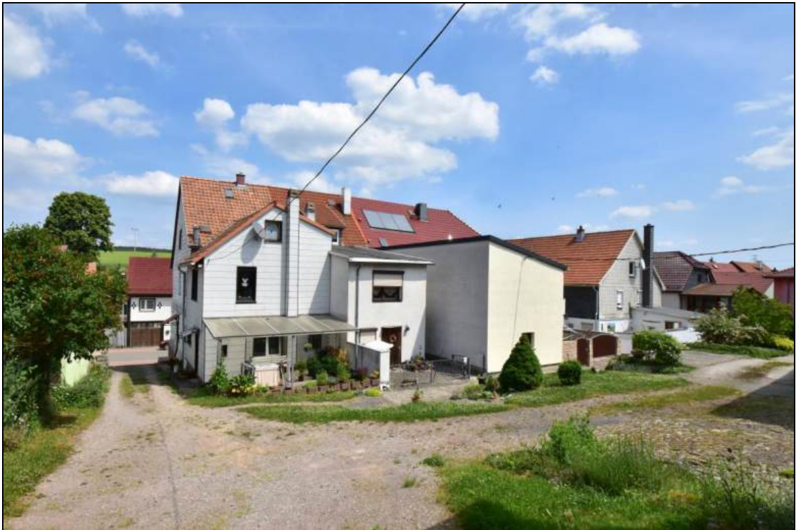
Gebäudekomplex-Hinterseite mit Erschließungszufahrt auf Flurstück 35 Südansicht
