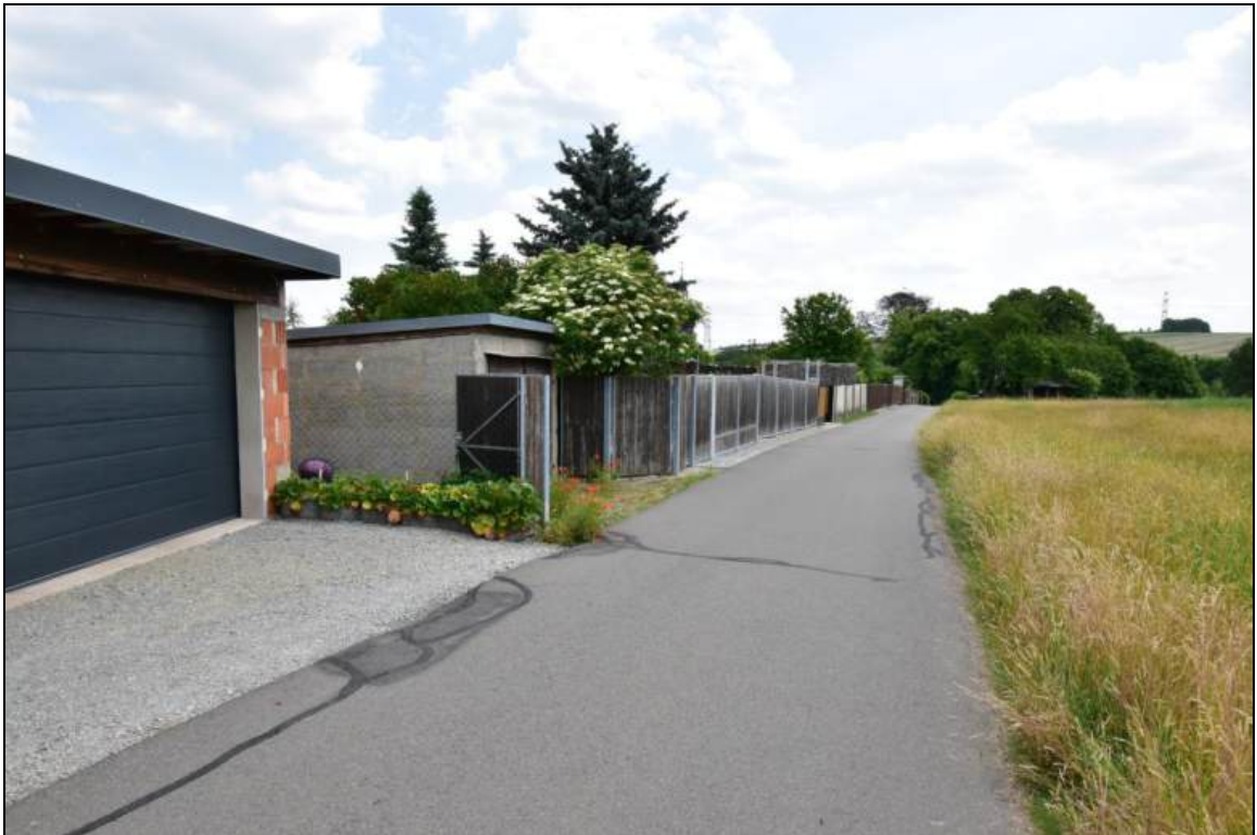
Westansicht mit Erschließungssituation
