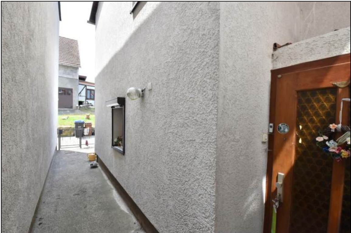
Durchgang mit Haustür Blick nach Süden
