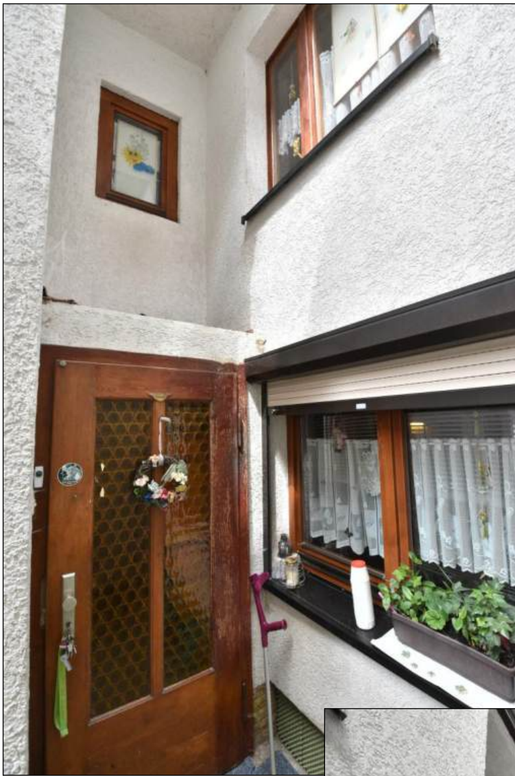
Wohnhaus, Hinterseite mit Hauseingangstür, Südostansicht
