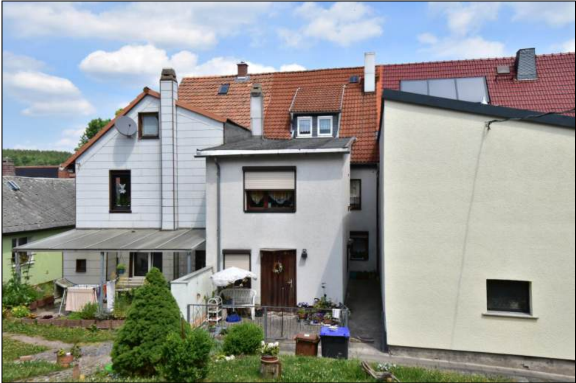
Gebäudehinterseite mit Anbau und Durchgang zum Eingang (Bildmitte) Blick nach Norden
