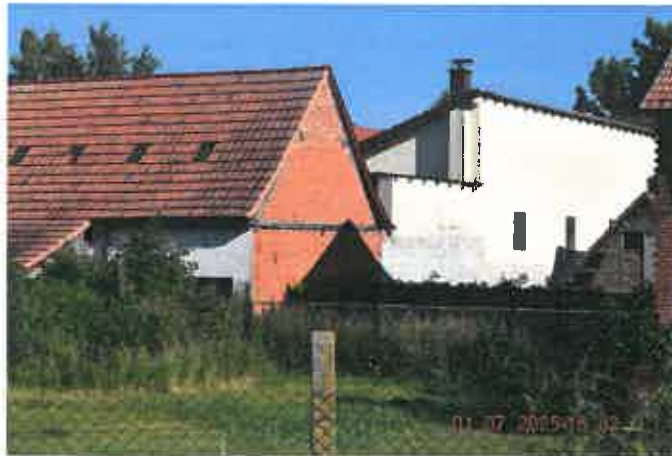
rückwärtige Ansicht Scheune/Wohnhausanbau
