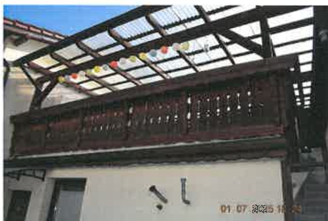
Terrasse am Wohnhausanbau
