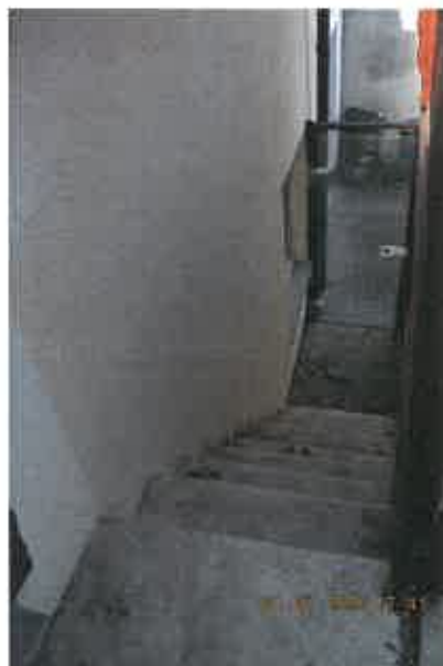
Außentreppe von Terrasse zum Hof
