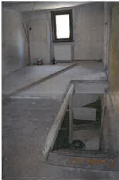
Diele mit Treppe zum EG
