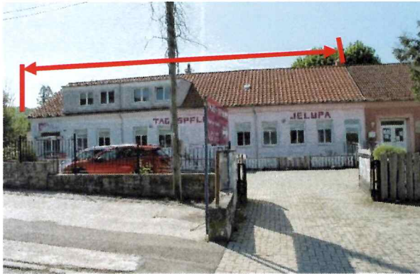
Straßenansicht mit Zufahrt
