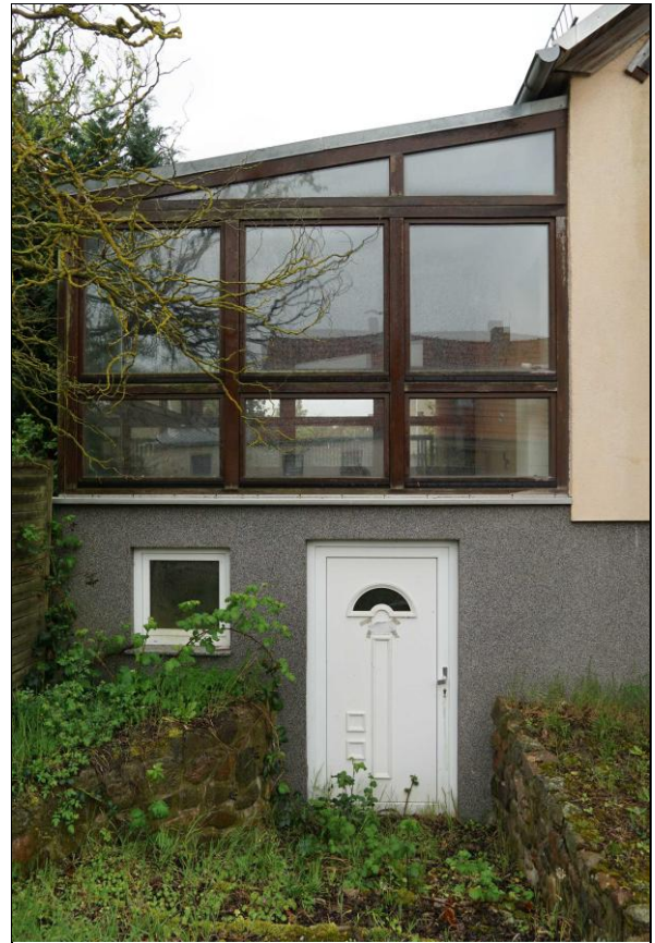
Wintergartenanbau mit Kellerzugang
