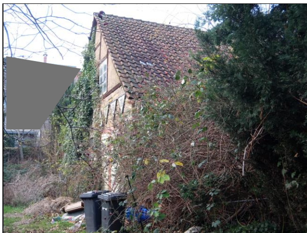
Ansicht Nebengebäude von Norden
