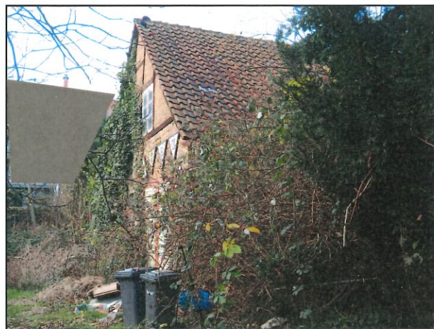
Ansicht Nebengebäude von Norden
