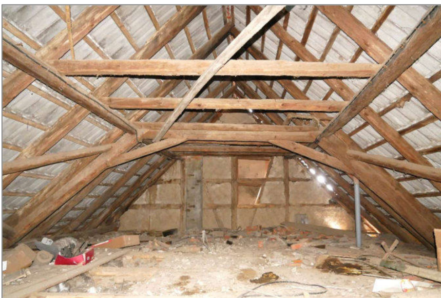
Foto 18 - Wohnhaus - nicht ausgebauter Dachboden
