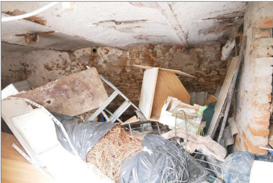
Foto 20 - Nebengebäude - Innenansicht EG
