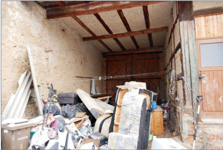
Foto 5 - Wohnhaus - überbaute Torfahrt EG
