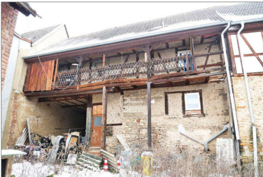
Foto 2 - Wohnhaus - Südansicht (Hofansicht)
