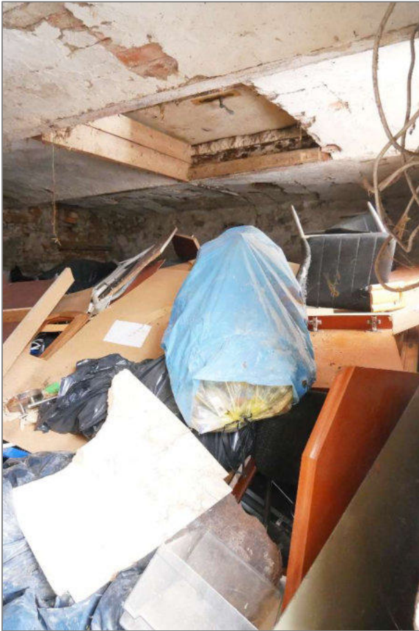
Foto 21 - Nebengebäude - Innenansicht EG
