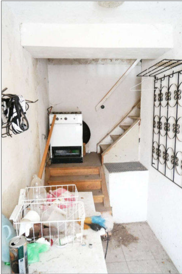
Foto 9 - Wohnhaus - Flur EG mit Treppe zum OG
