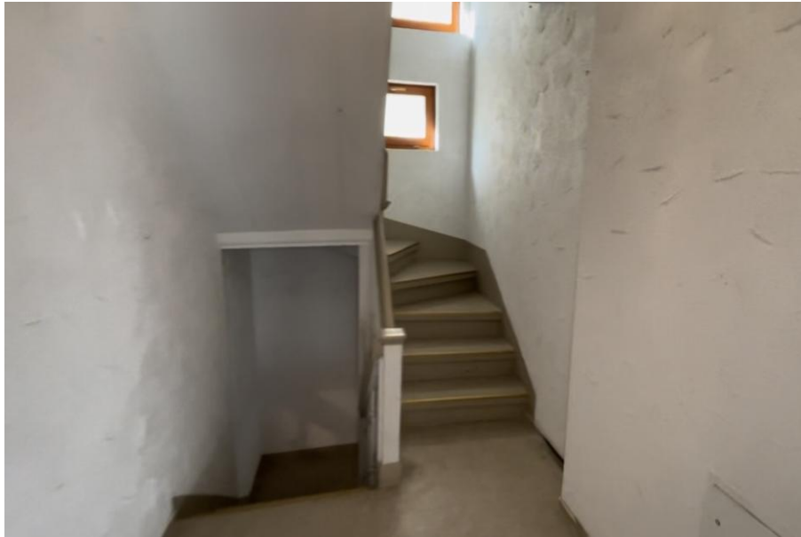
Treppenhaus und Ausgang zum II.OG
