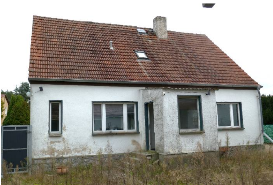
Foto 2, Hofansicht, Einfamilienhaus (Geb. 1) mit Windfanganbau, Westansicht
