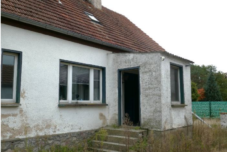
Foto 3, Hofansicht Einfamilienhaus (Geb. 1), Windfanganbau, Nordwestansicht
