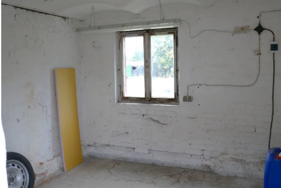
Foto 21, beispielhaft ein Abstellraum
