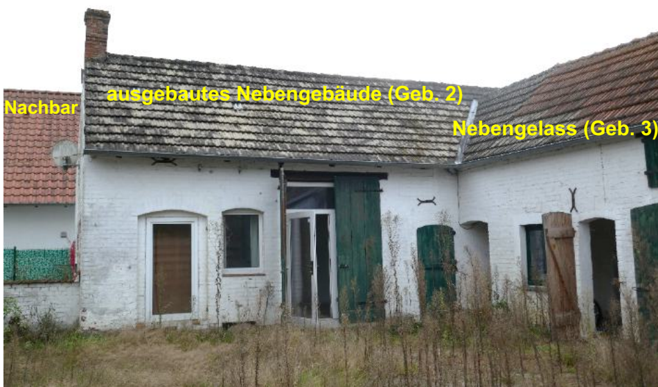
Foto 4, ausgebautes Nebengebäude (Geb. 2) und angrenzend Nebengelass (Geb. 3), Nordostansicht
