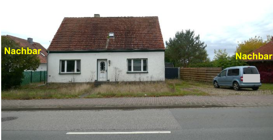
Foto 1, Blick von der Jävenitzer Straße, Bundesstraße 71, zum Grundstück mit Einfamilienhaus (Geb. 1), Ostansicht
