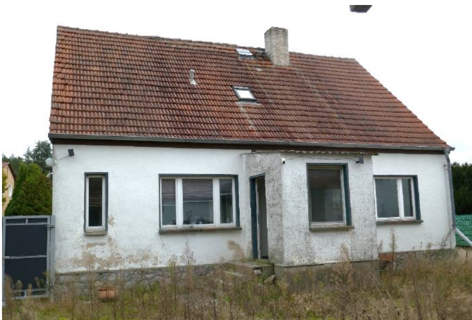
Foto 2, Hofansicht, Einfamilienhaus (Geb. 1) mit Windfanganbau, Westansicht
