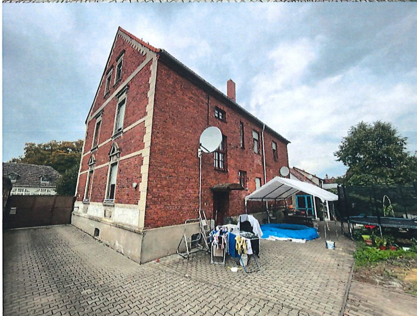
Wohn- und Geschäftshaus (Hofansicht)
