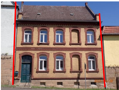
Ansicht von der Straße Fassade etwa südorientiert
