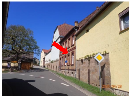
Straßenzug - Blick Richtung Westen Versteigerungsobjekt mit Pfeil gekennzeichnet
