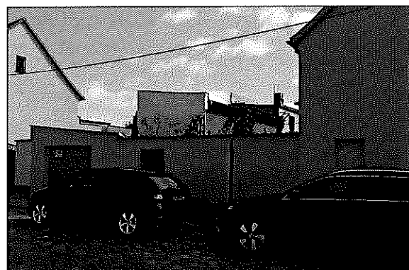
Ansicht des Bewertungsobjektes von der Schloßstraße aus
