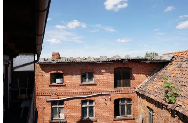
Ansicht der Nebengebäude
