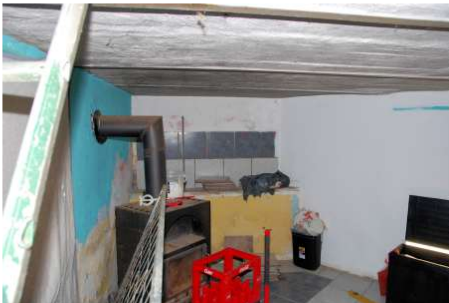
Foto 25 Leinstraße 26, Nebengebäude, Erdgeschoss
