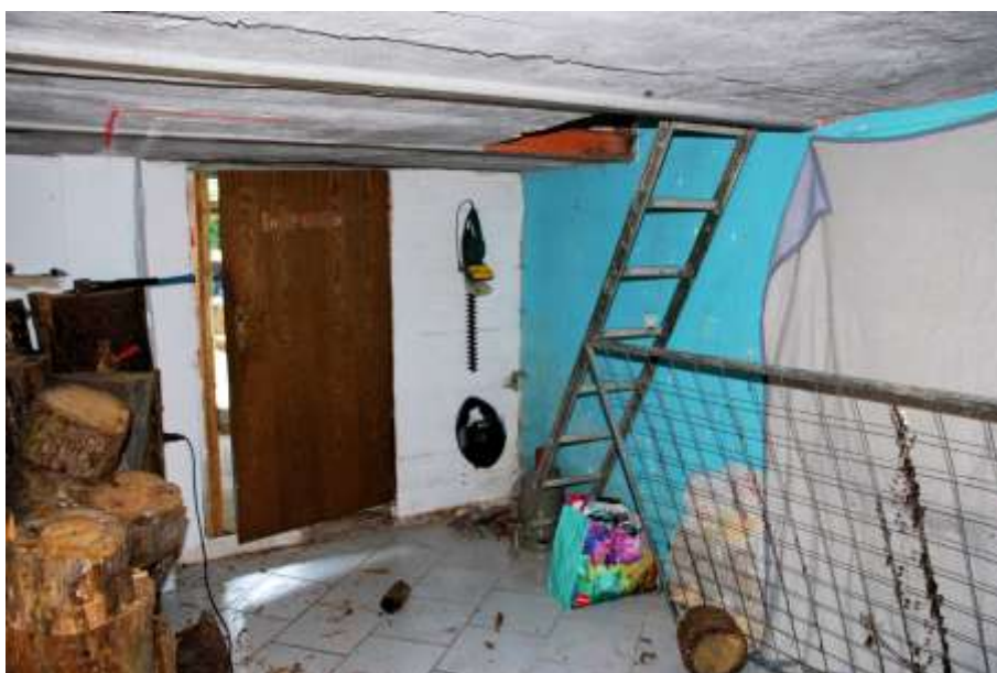
Foto 26 Leinstraße 26, Nebengebäude, Erdgeschoss
