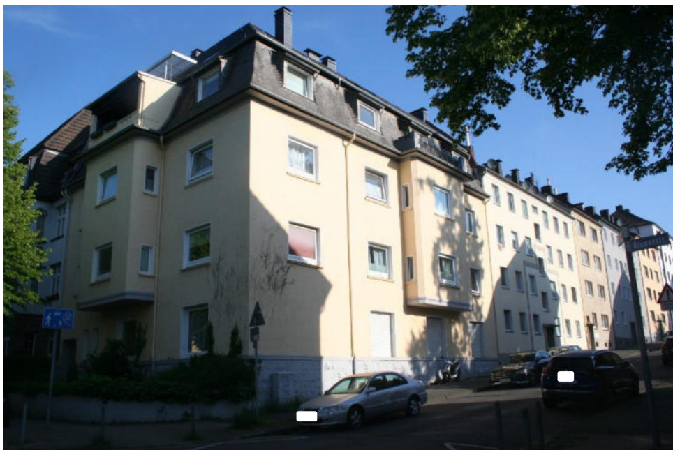
Bild 4: Straßenansicht / Südwestansicht Blumenstraße und Südostansicht Königstraße
