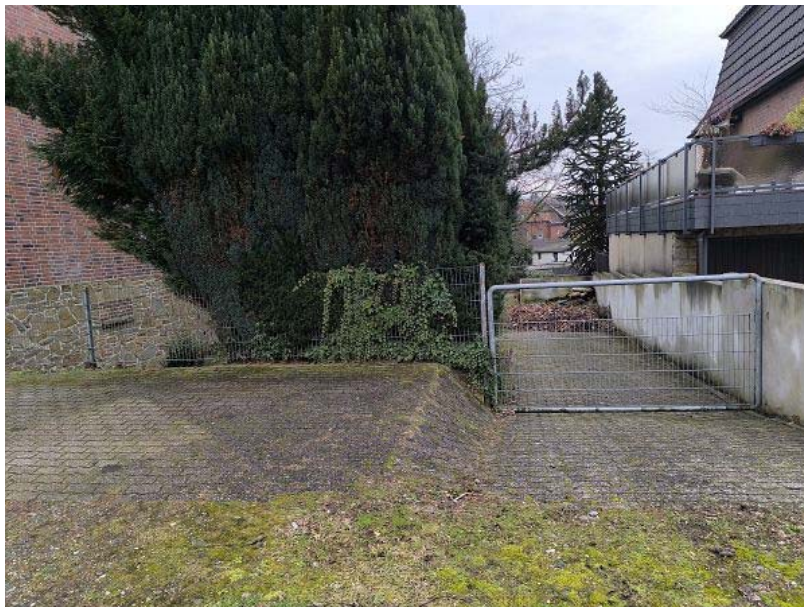
Straßenansicht / Hofzufahrt zu Flst. 447 auf Flst. 448
